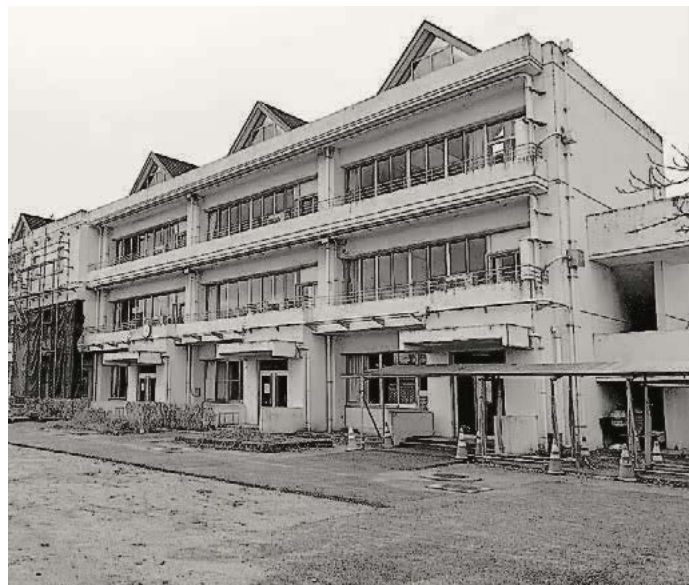
児童の快適な環境づくりへ、トイレ改修が進められている南小学校
