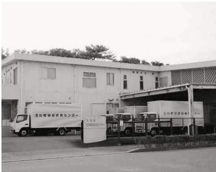
厨房機器等の老朽化が見受けられるため、更新し施設の長寿命化を図る学校給食センター
