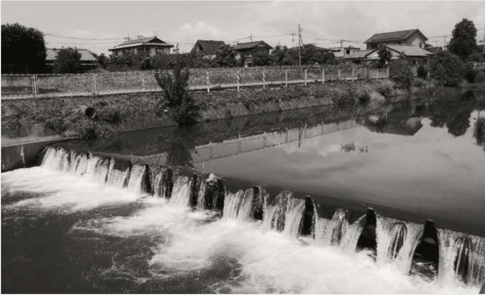
起伏ゲート等を調査。農業用水の安定した送水には不可欠（樋越堰）
