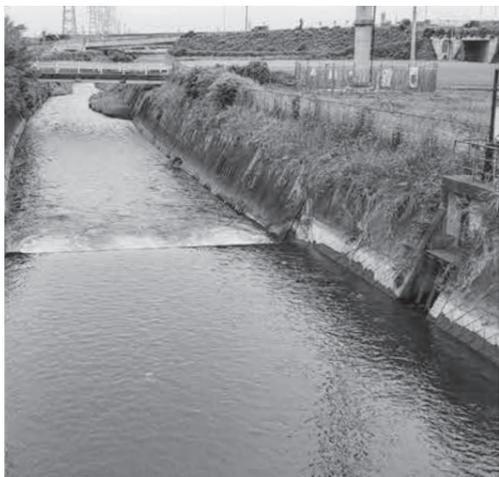
約50年が経過し老朽化が進んだ第二統合堰
