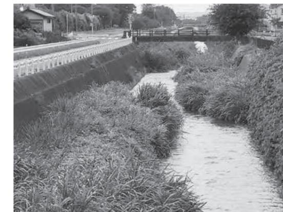
河川内に土砂が堆積、雑草が繁茂し水路幅を大きく遮っている。
