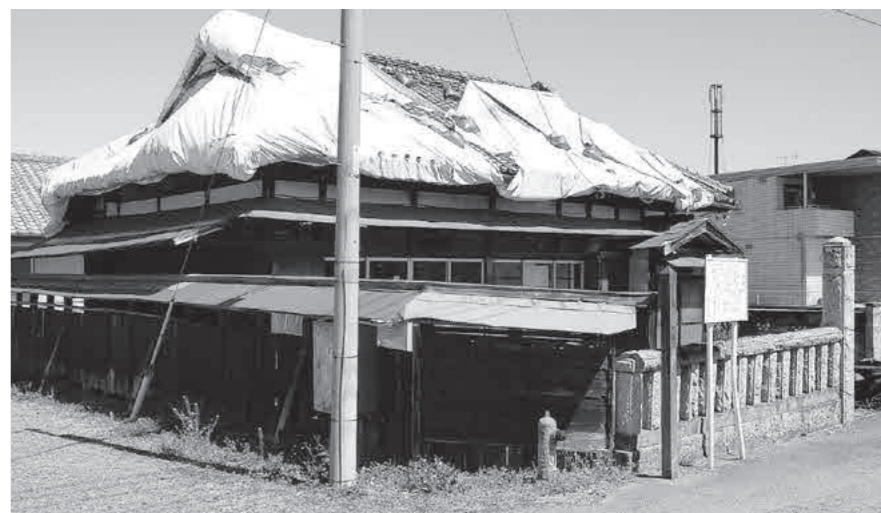
保存・改修工事を始める嚮義堂（上樋越）
