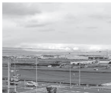
高崎玉村スマートIIC北地区 工業団地の造成状況
