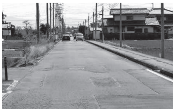
拡幅が待たれる藤岡大胡線バイパス
