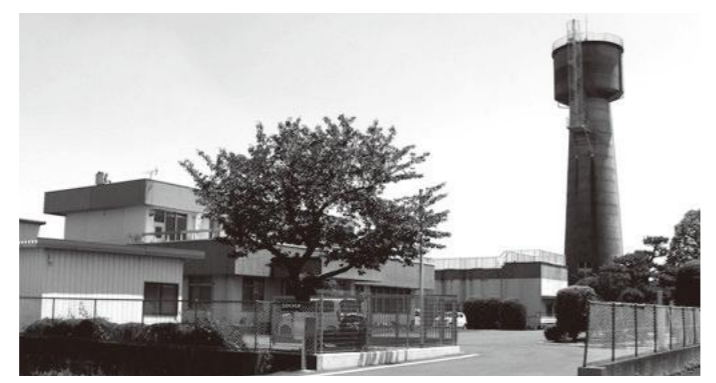
老朽化が進む水道施設
