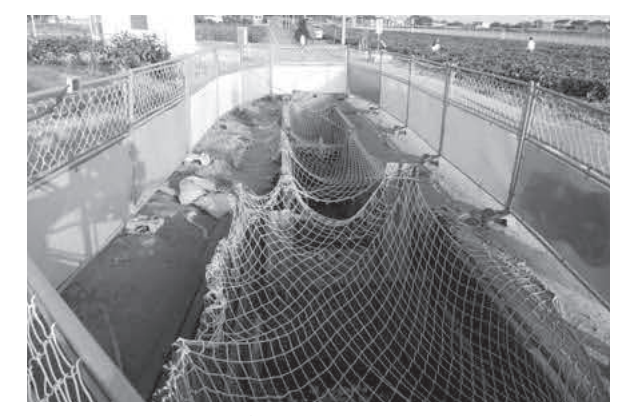
急がれる下水道整備
