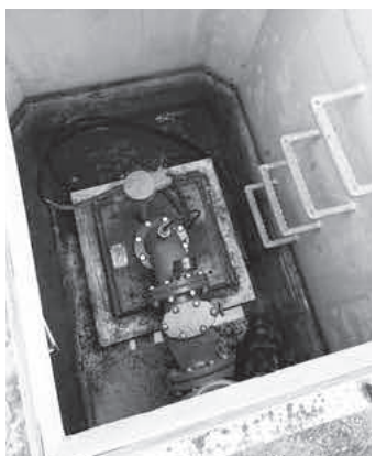
水源内部（写真は第11水源）
