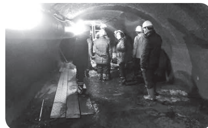
利根川の真下を横断する暗渠内
