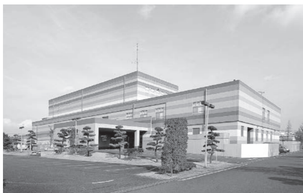
インフラ施設等の更新が迫る
