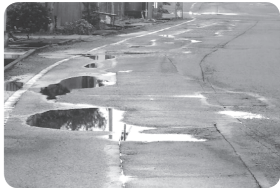
ひび割れ、でこぼこの激しい町道
