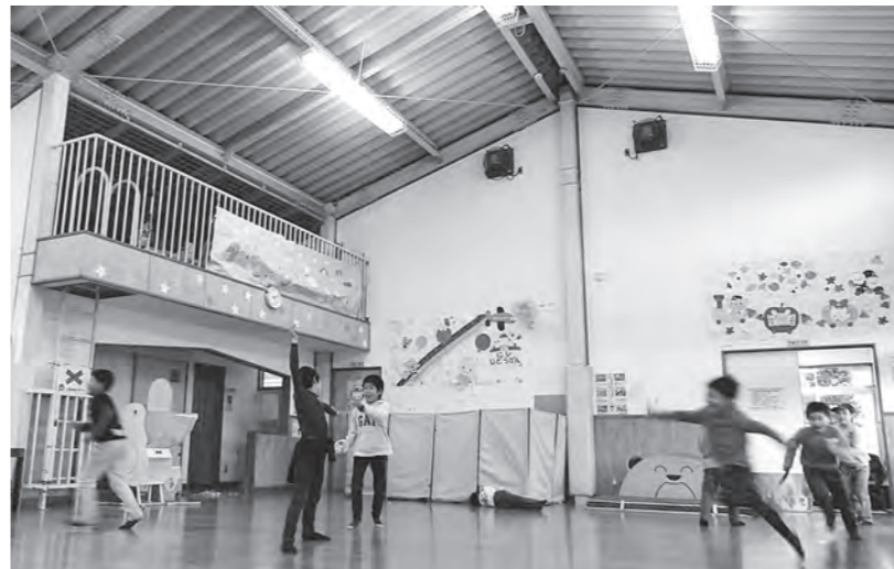
エアコンが設置される児童館ホール
