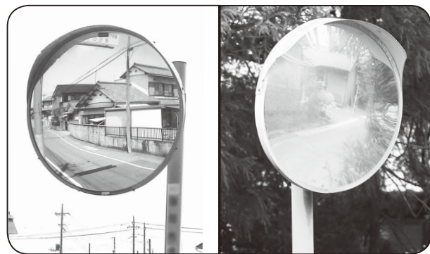
強化ガラス製(左)とアクリル製(右)のカーブミラーの比較(ともに昭和時に設置)
