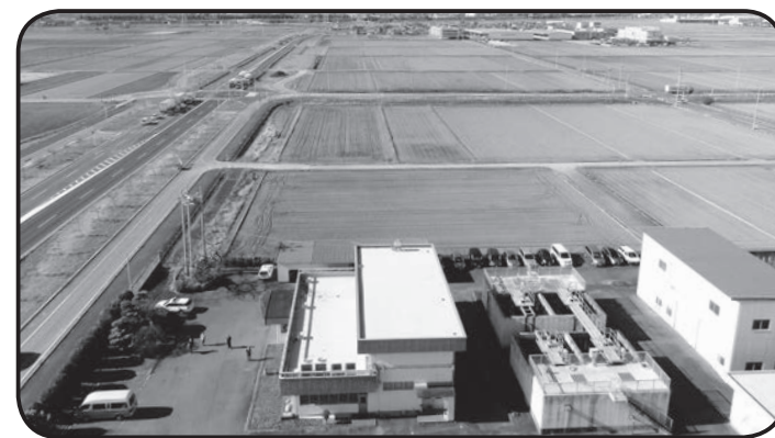
給水塔から見た水道庁舎と水道施設
