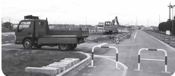
町が行う公共工事
