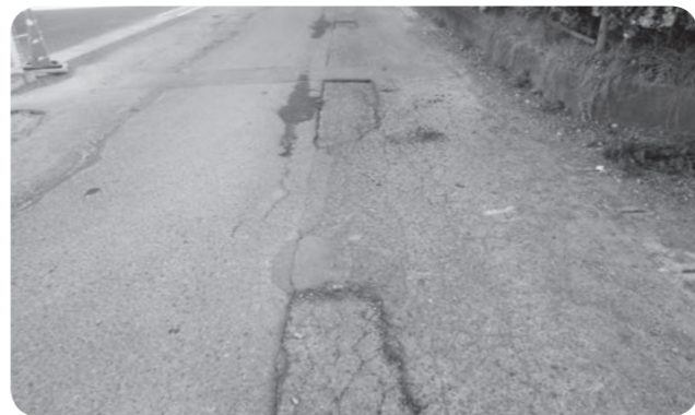
傷みが激しい住宅団地内道路
