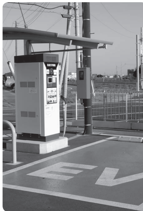
普及が進むEV充電スタンド
