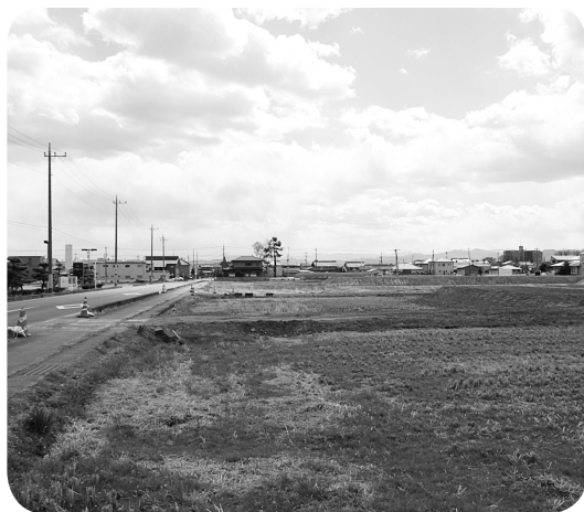
造成が始まった文化センター周辺地区
