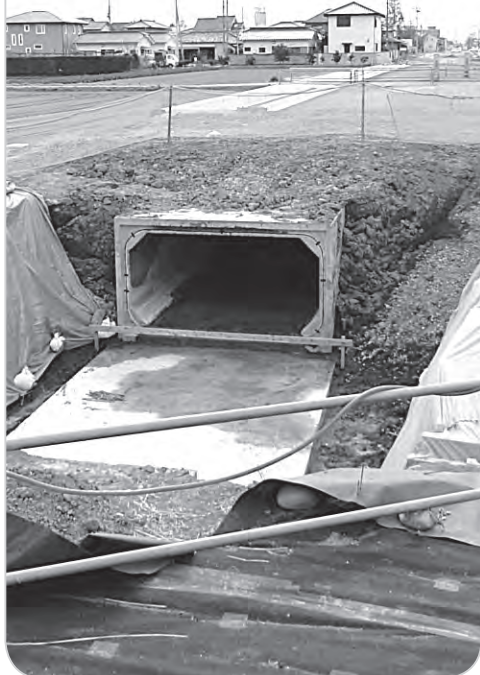
雨水滝3号幹線設置工事 (上の道路は斉田上之手線)
