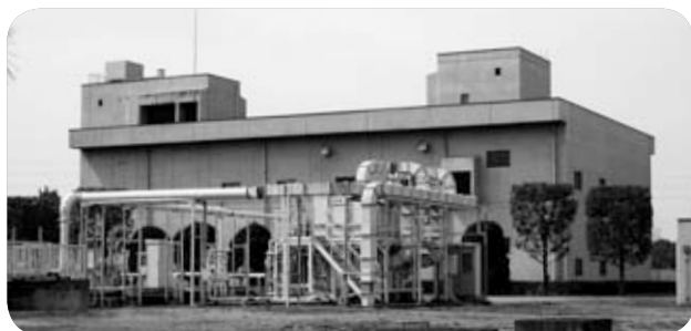
県中央水質浄化センター
