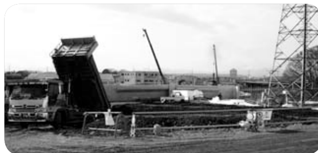
工事が進む東毛広域幹線道路（スマートIC付近）
