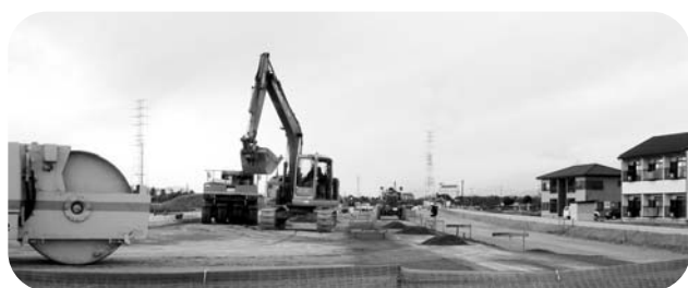
スマートIC供用開始に向けて、工事が進む354号バイパス
