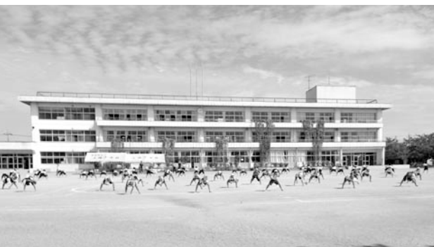
工事中は、校庭等の利用が制限される上陽小学校
