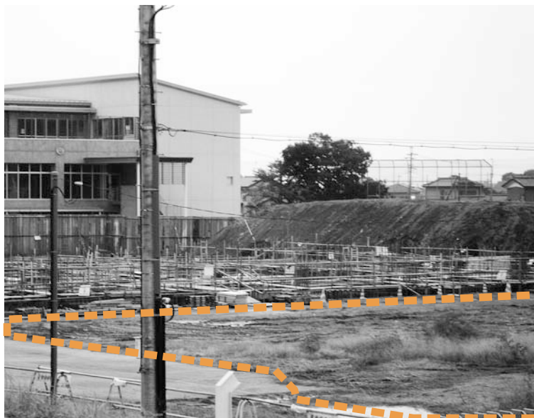
点線枠内が玉村中学校プールの建設予定地 (予定地の隣は体育館の基礎工事)
