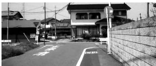
下新田地内の変則4差路 東西の歩道がない
