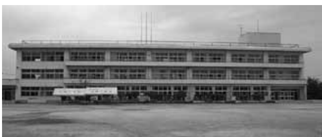
耐震補強が進められる上陽小学校
