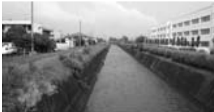
請願箇所の一部である滝川兩岸(南中学校北)
