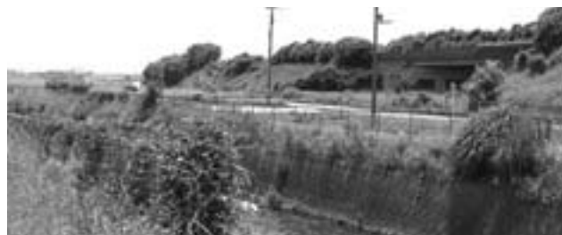
スマートインターチェンジ 予定地
