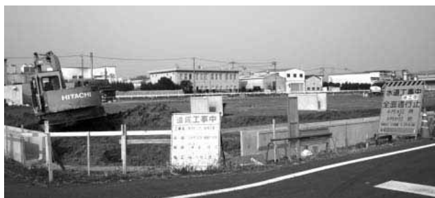
造成工事が始まった北部工業団地
