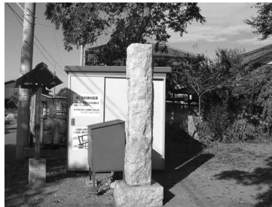
洪水時に使用する資材を保管している烏川水防資材倉庫（川井地内）
