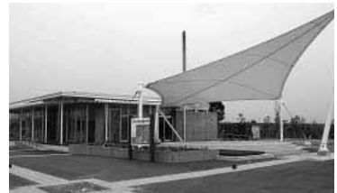
北部公園 管理棟
