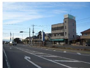
東毛広域幹線道路 （国道354号バイパス）
