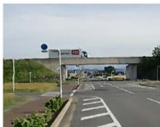
国道 354 号バイパス (高架部分)
