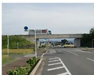
国道 354 号バイパス(高架部分)
