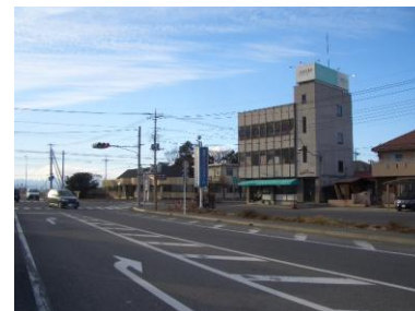
東毛広域幹線道路 （国道354号バイパス）
