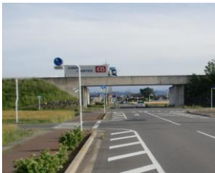
国道 354 号バイパス（高架部分）
