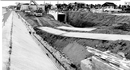
坂東大堰地区天狗岩暗渠改修工事 (吉岡町地内)
