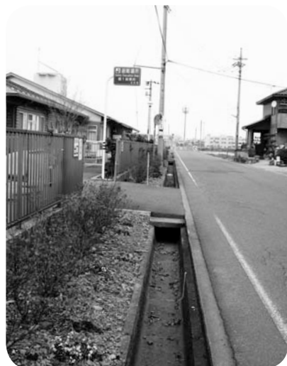
緊急避難所（第1保育所）東側の溝
